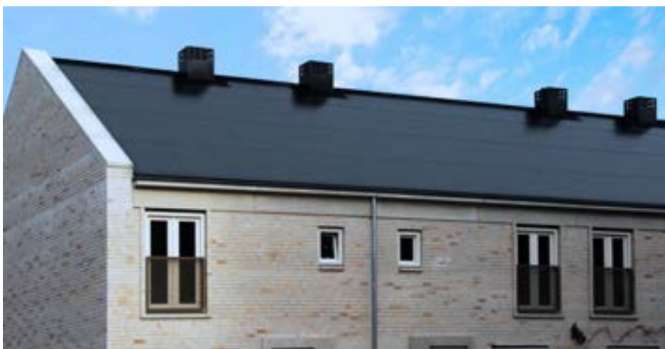
Bright House, Heijmans. Het dak combineert opwekking van elektriciteit en warmte.
